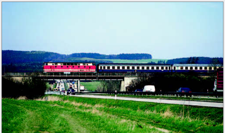
Aktueller Anlass für die Stilllegung der Strecke Triptis – Ebersdorf-Friesau ist diese Eisenbahnbrücke bei Moßbach über die Autobahn A 9. Sie kann jetzt abgerissen werden, ohne dass man sofort ein Ersatzbauwerk errichten zu müssen. Im Fall der Reaktivierung muss die DEGES eine neue Brücke bauen, Aufnahme vom Mai 1997. Aufn.: EK
