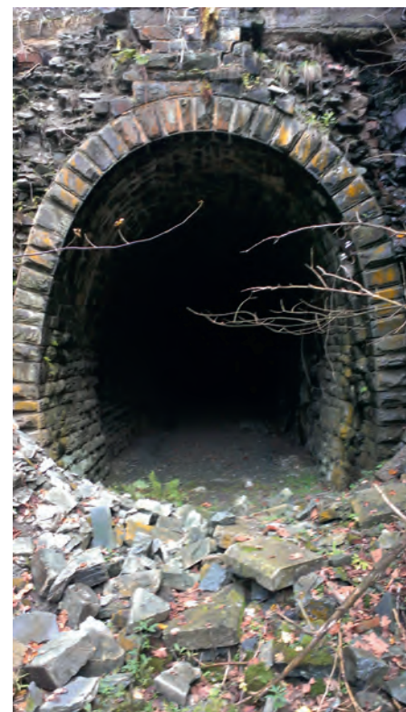
Abb. 3: Nordportal des Kesselfelstunnels
